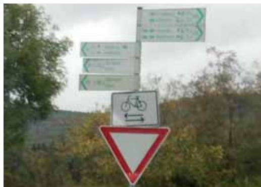
Abbildung 23: Die Anbringung von Radwegweisern in Kombination mit dem Verkehrszeichen "Vorfahrt gewähren" ist unzulässig
