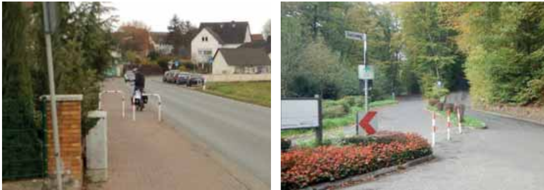
Abbildung 14: Umlaufsperrern oder zu eng positionierte Sperrpfosten stellen ein Hindernis dar für Radfahrende mit Gepäck und Anhänger sowie für Lastenfahrräder
