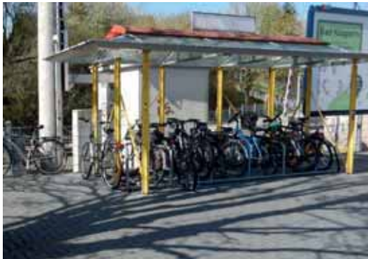
Abbildung 15: Überdachte Fahrradabstellanlage am Bahnhof Köppern
