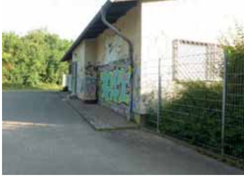
Fehlende Abstellanlagen beim TV Burgholzhausen
