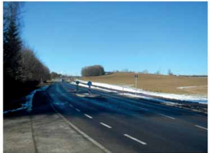
Abbildung: Beispielhafter Überführung Radweg - Fahrbahn in Tuningen
